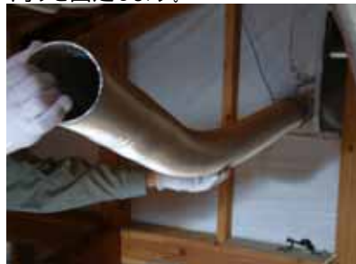
パイプフードに取り付けたアルミダクトを本体まで伸ばし粘着テープで固定します。
