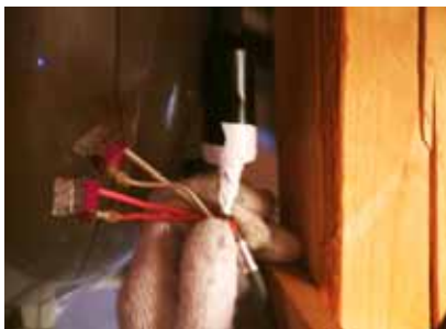
全てのコネクタにキャップを被せて ビニルテープを半幅以上重ね 3回以上巻いて固定してください。
