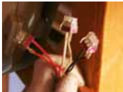
段剥きしたVVFケーブルをコネクタに強く差し込んでください。(CF-240の場合)
