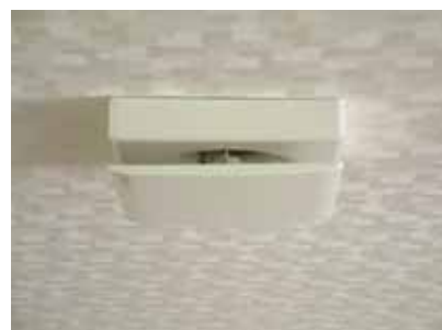
換気システムと連動しているか動作チェックをして取り付け完了。
