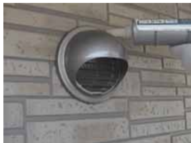
市販のコーキング材でパイプフードの周りを固定します。
