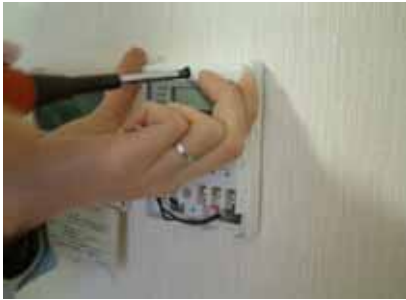
コントローラーをねじで固定します。
