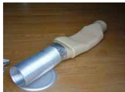
カットしたアルミダクトをフレキシブルカップリングに 粘着テープで固定します。
