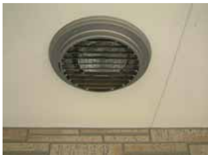
ルーバーをネジで固定する。 外側に吹出し風が出るようルーバー向きに注意すること。
