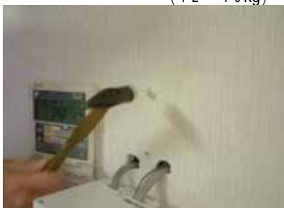
6の下穴を開けプラスチックアンカーを打ち込みます。
