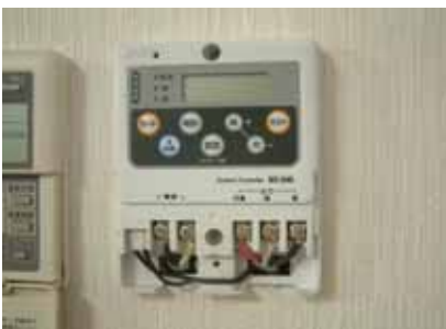
端子カバーをかぶせて必ずねじで固定してください。
