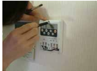
取付け用下穴の位置決めをします。
