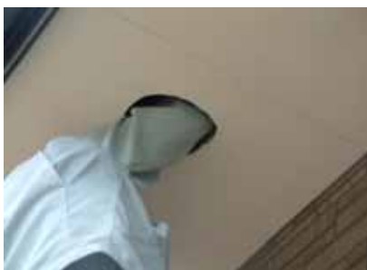
軒天に入れたフレキシブルカップリングを 天井裏へ差しこみます。 アルミダクトは軒天板の穴から外側に 出してください。
