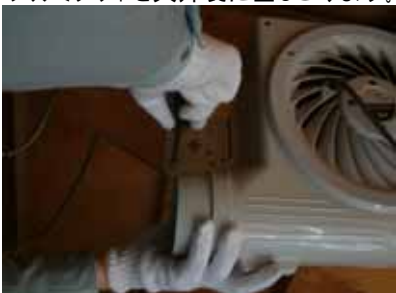
本体を天井裏の中央の高さに取り付けます。
