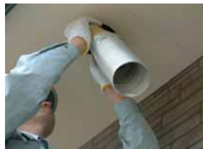
フレキシブルカップリングを 軒天板の穴から軒先へ差しこみます。
