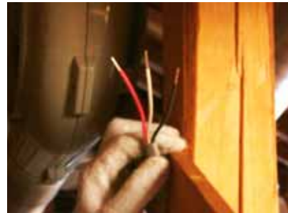
VVFケーブルを10～13mm段剥きし、 曲がり等があれば直してください。
