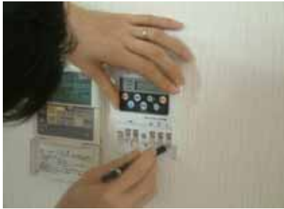
コントローラーの取り付け位置を決める。
