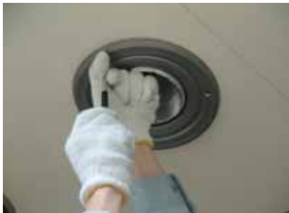
丸・平型換気口を軒天側に押込んでネジで固定する。
