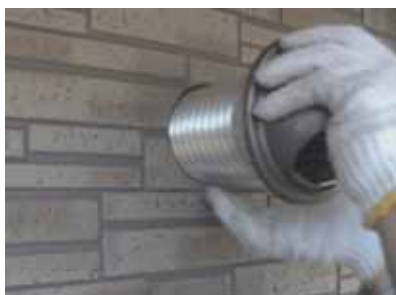
外壁側からパイプフードを取付けたアルミダクトを天井裏に差しこみます。
