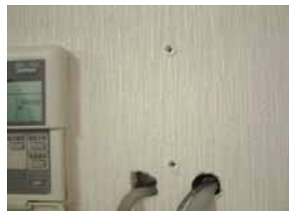
パネルなどの壁面に取り付ける際は プラスチックアンカーを使用してください。
