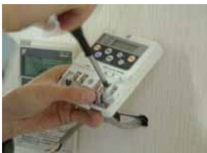
電線の先端が突き当たるまで差込み 端子ねじを確実に締めます。 適正締め付けトルク 1.2 \sim 1.6 \text{ N} \cdot \text{m} ( 12 \sim 16 \text{ kg} )
