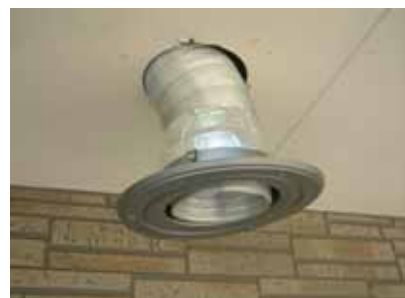
丸・平型換気口のルーバーを外しアルミ ダクトを内径に挿入し、先端を換気口吹出 し面にあわせて粘着テープで固定する。
