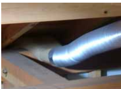
天井裏側のフレキシブルカップリングとアルミダクトを粘着テープで固定する。
