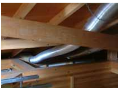
フレキシブルカップリングに固定したアルミダクトを本体まで伸ばし、粘着テープで固定する。
