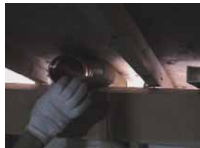
天井裏に差し込んだフレキシブルカップリングの位置を決め、先端の形を整えてください。
