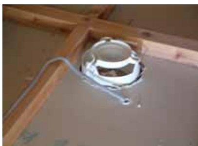
天井裏から見た補強材との位置関係。
