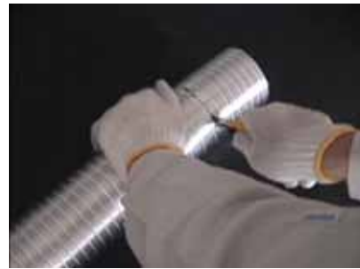
アルミダクトを3～400mm長に カットします。
