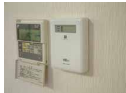
最後に動作チェックをしてタイマーカバーをかぶせて結線完了。
