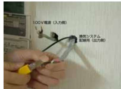
天井裏の本体からの配線を引き出し VVFケーブルを段剥きする。
