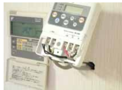
結線完了。 電線の色に注意してください。
