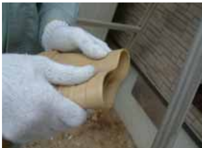
天井裏側へ差し込むフレキシブルカップリングの 先端をつぶしておくとしこみがスムーズです。
