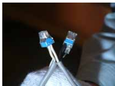
コネクタにキャップを被せてビニルテープを半幅以上重ね3回以上巻いて固定してください。
