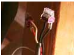
段剥きしたVVFケーブルをコネクタに強く差し込んでください。(CF-400の場合)
