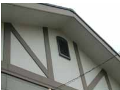
施工前の外観
